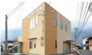
■くれよん薬局 約 0.05km
